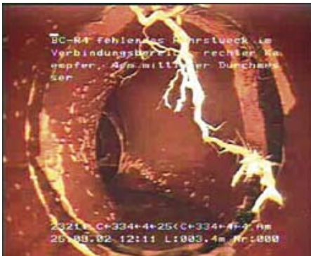
Bild 1: Schadhafte Grundleitung
