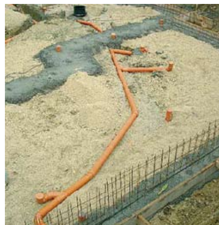
Bild 2: Verlegung von Grundleitungen
