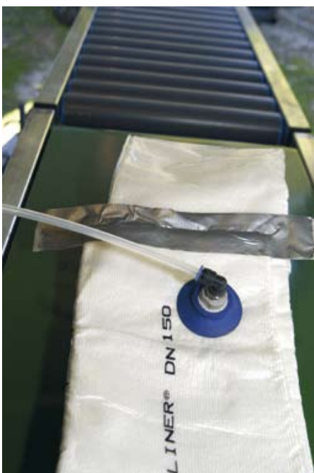
Bild 8: Erzeugung Vakuum an Schlauchliner
