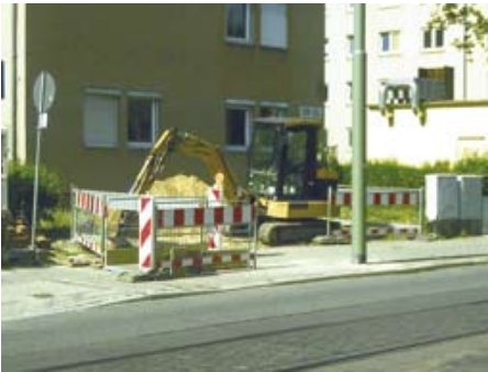
Bild 3: Sanierung Hausanschluss an der Grundstücksgrenze
